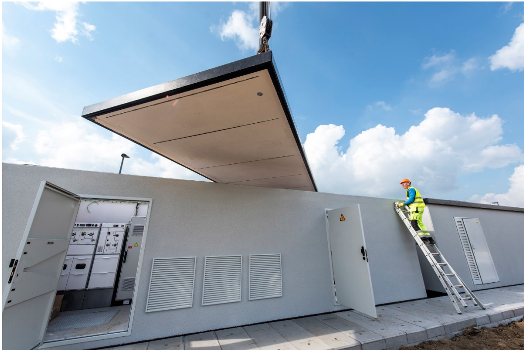
Installatie van een cabine in het Green Energy Park in Zellik
