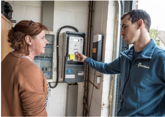
installatie van een digitale meter
